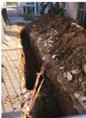
Une importante fuite d'eau (800 m<sup>3</sup> d'eau au lieu de 200 m<sup>3</sup> sur la même période 2016) a été réparée devant la mairie par les employés communaux. Le service technique a dû réaliser une tranchée sur 20 m afin de remplacer la canalisation d'adduction d'eau défectueuse.
